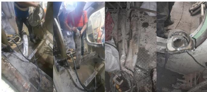
Figura 10. Haste identificada e cortada segundo procedimento criado
