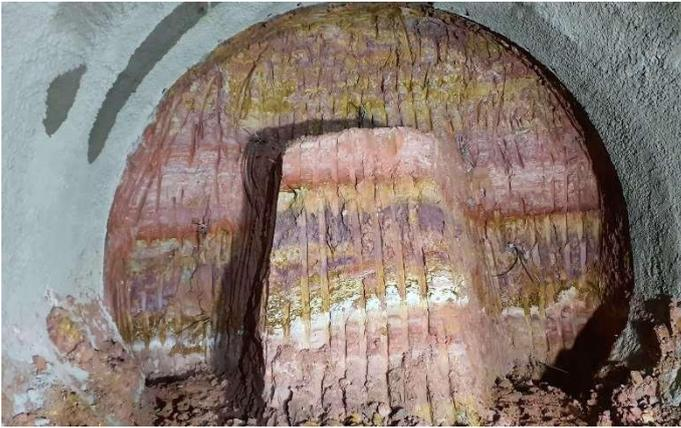
Figura 4 – Feição típica da Formação São Paulo observada no túnel piloto do túnel de plataforma norte.
