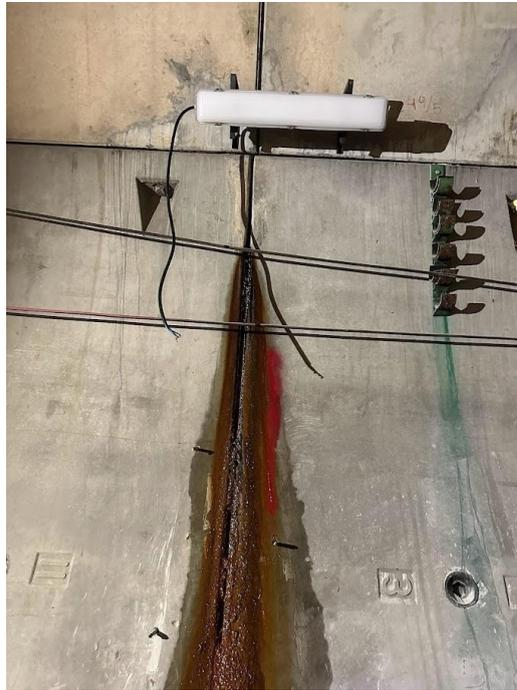
Figura 5 Vazamento com carreamento de finos
