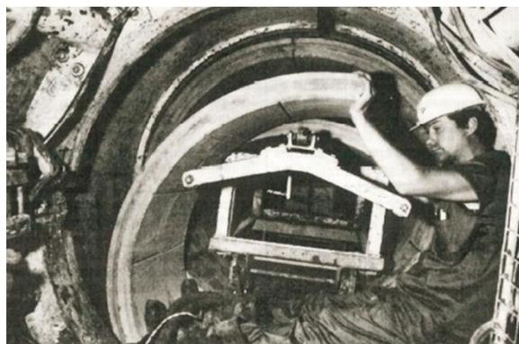
Foto 03. Montagem manual dos anéis no *Shield Seerflex*, diâmetro 1,20 m Fonte: Acervo Construtora Passarelli
