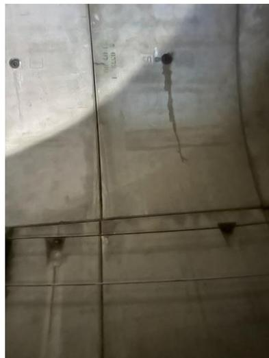
*Figura 2 Regiões com infiltração sem grande fluxo de água*
