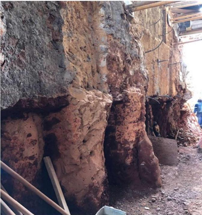
Figura 6. Detalhe de blocos formados por colunas Jet Grouting no reforço das fundações.
