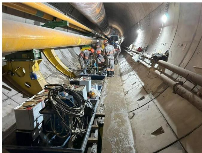
Figura 13 Instalação dos bicos de injeção
