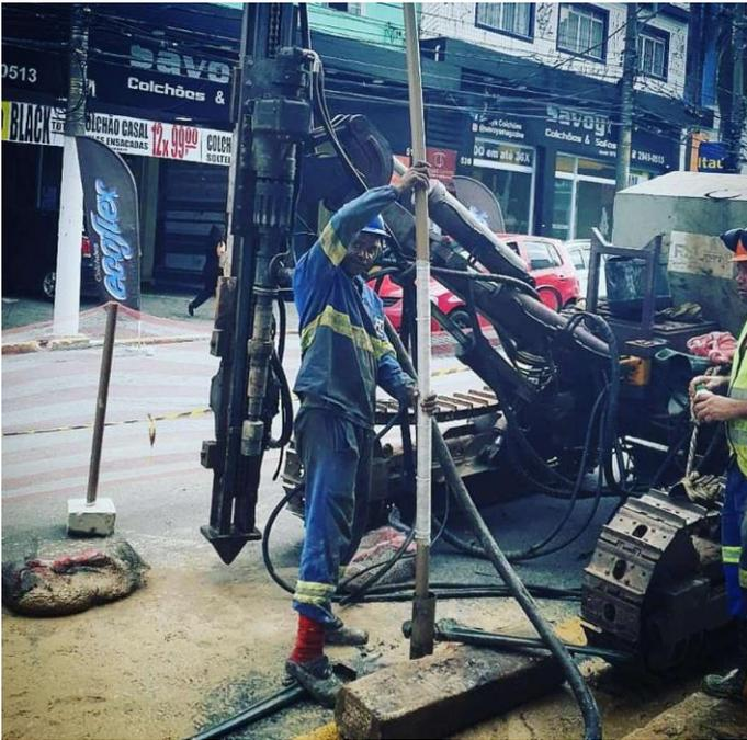
Figura 2. Instalação de piezômetro em trecho de túnel de via na região do Jardim Japão.
