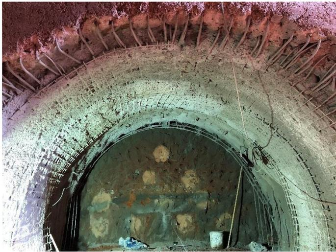
Figura 25 – Colunas de CCPh na frente de escavação.
