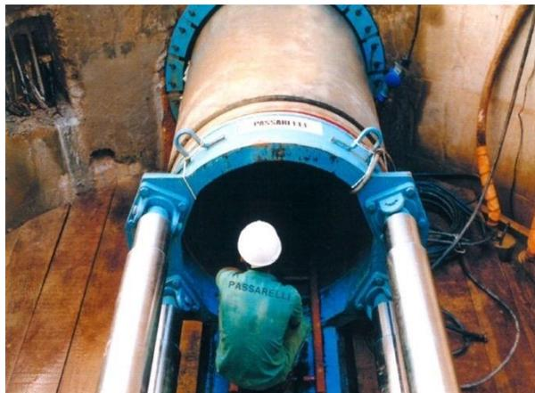
Foto 14. Tubo cravado a partir de 04 cilindros hidráulicos telescópicos. Fonte: Construtora Passarelli S/A.
