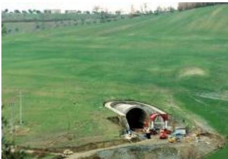
Figura 6: Exemplo de túnel iniciado sob a técnica AGO. Fonte: Lunardi, 2008.
