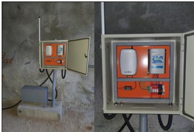
Figura 7. Quadro de comando do sistema de monitoramento.
