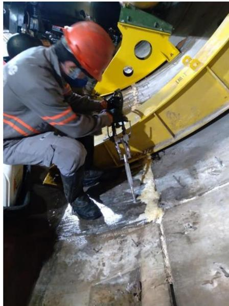
Figura 16 Resina sendo injetada
