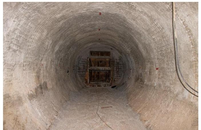
Figura 24 – Revestimento estrutural e desemboque no poço do elevador concluídos.
