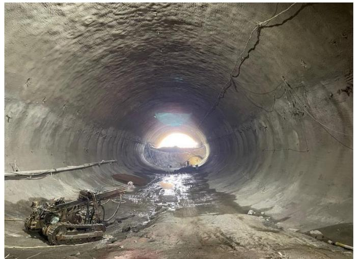
Figura 12. Trecho a ter o arco invertido definitivo executado, em dez/2024. Fonte: Autor.
