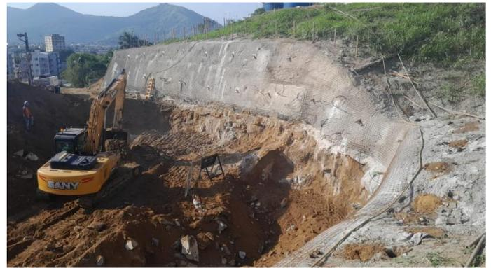
Figura 25 – Execução do emboque sul
