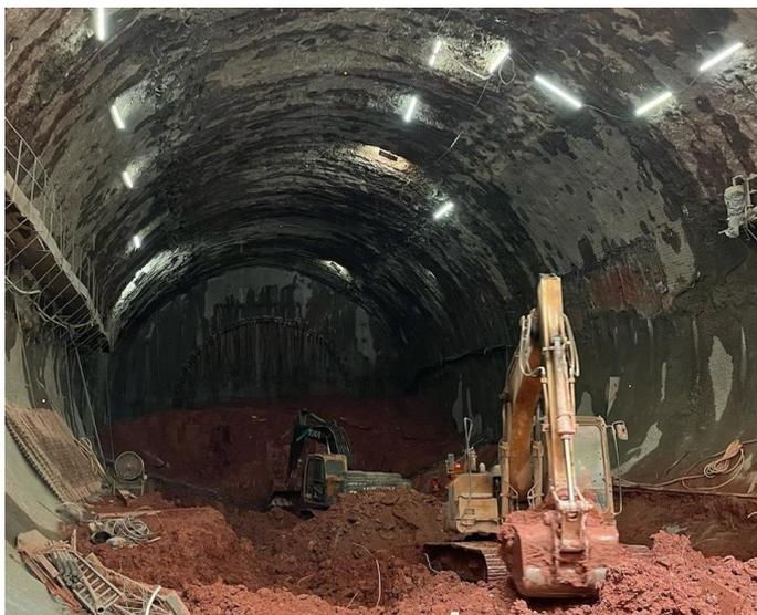
Figura 13 – Finalização da escavação do arco invertido definitivo do Túnel Sul
