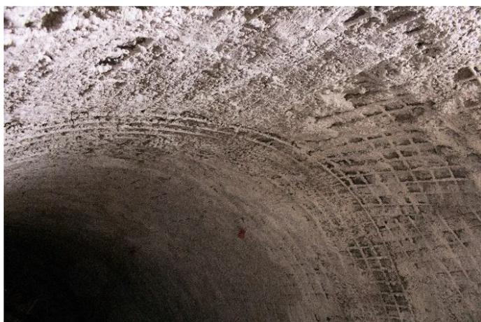
Figura 15 - Tela metálica Q396 no revestimento secundário.
