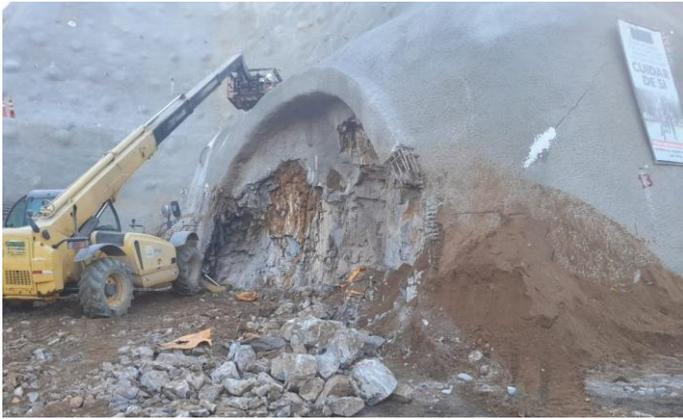
Figura 17 – Presença de solo na lateral do eixo 1000
