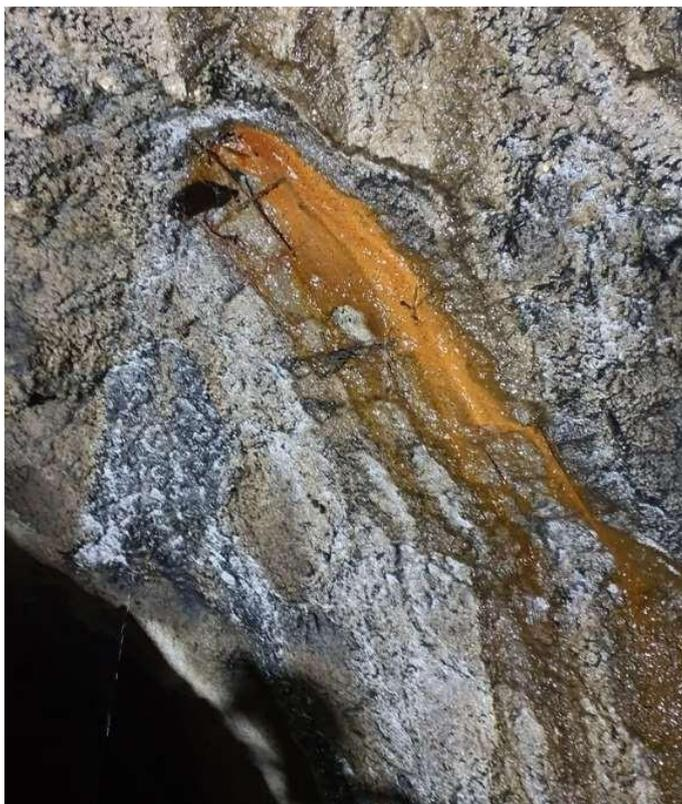
Figura 4: Formação de colóide ao longo de um trecho do túnel.
