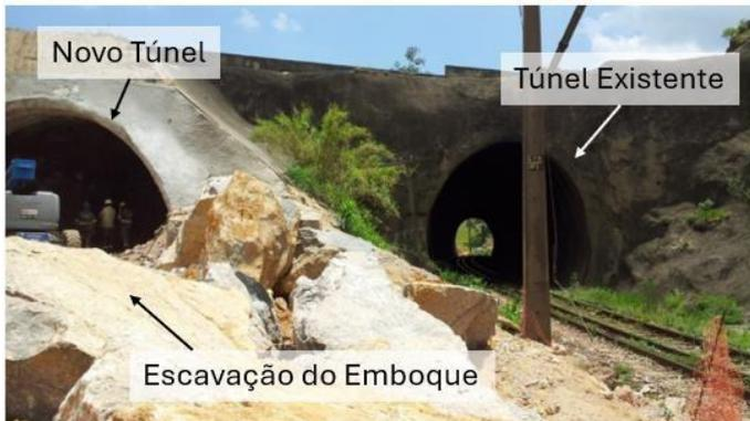
Figura 4. Localização do novo túnel ferroviário e seu emboque nas proximidades do túnel existente em operação. Fonte: Adaptado de Leite e Lapolli (2015)
