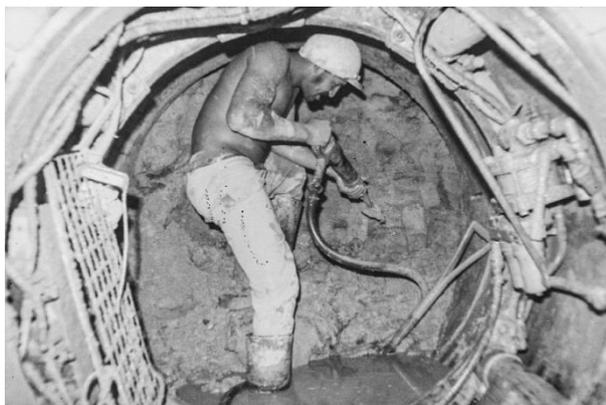
Foto 04. Foto antológica e mostra a primeira obra no Brasil, em 1974, de um coletor-tronco da Sabesp utilizando um *Shield* mecanizado. Fonte: acervo Construtora Passarelli.
