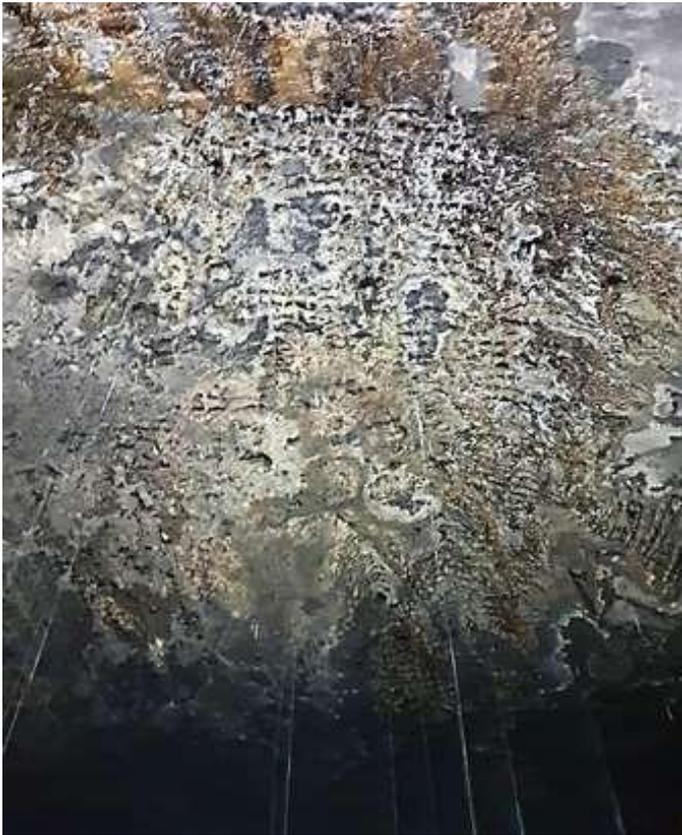
Figura 3: Jorros de água na abóboda do túnel.
