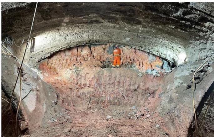
Figura 12 – Escavação da calota do Túnel Norte, onde é possível visualizar algumas colunas de JG.
