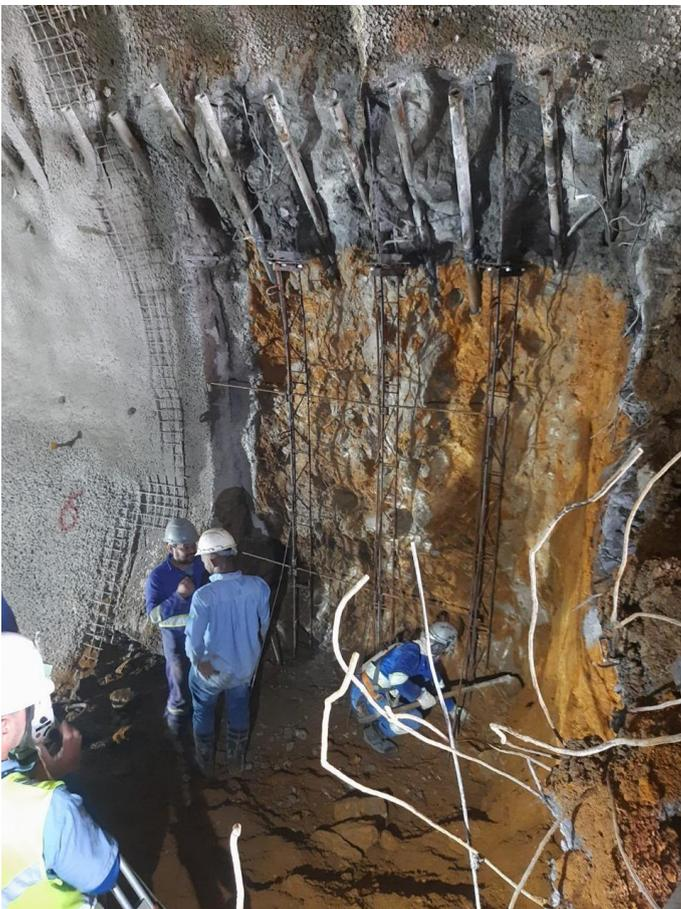
Figura 14. Execução do arco invertido definitivo, em dez/2024.
