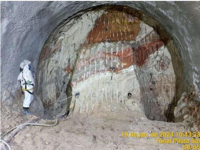
Figura 5 – Feição típica apresentada pelo Complexo Embu (pré-Cambriano), no túnel piloto do túnel de plataforma sul.
