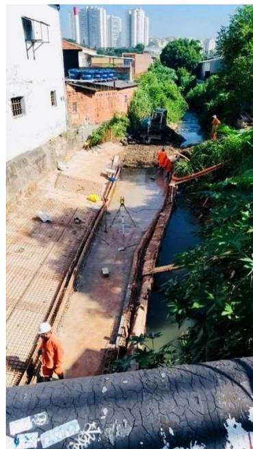
Figura 14. Aspecto da reconstrução do canal do Córrego Itararé.
