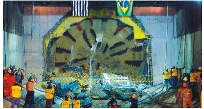
Foto 25. Chegada do *Shield* no poço de serviço da Estação Fradique Coutinho, Linha 4 amarela em 2007. Fonte: *Herrenknecht do Brasil* (Eng. Edson Peev)
