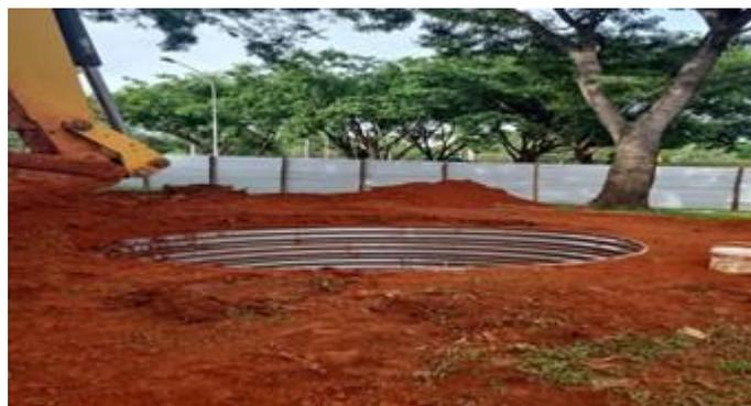
Figura 3. Poço de Ataque do Drenar DF. (Fonte: Terracap)
