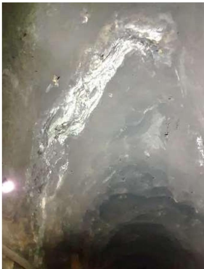
Figura 2: Progressão de queda de blocos formando uma geometria em forma de capelas (“capelamentos”).
