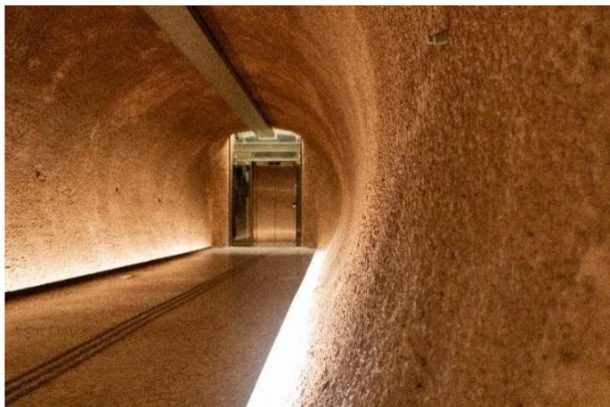
Figura 11 - Camada final do revestimento secundário com concreto projetado pigmentado.
