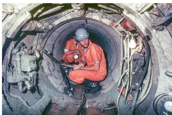
Foto 06. Equipe de topografia realizando nivelamento e alinhamento do mini túnel, coletor-tronco 9 de julho da Sabesp em 1979. Em primeiro plano à esquerda vê-se a bomba hidropneumática inglesa. Fonte: acervo próprio do autor
