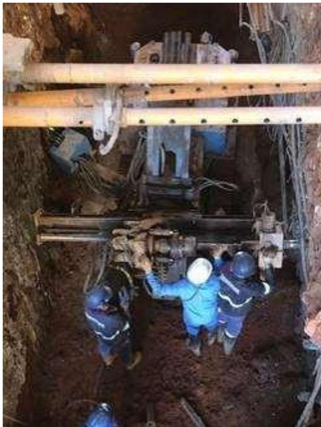
Figura 17. Equipamentos de pequeno porte adaptados para execução dos tratamentos em espaços restritos.
