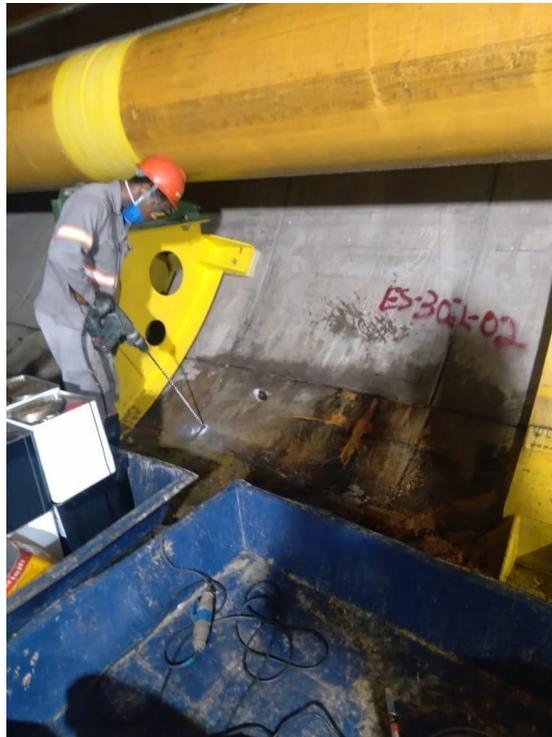
Figura 12 Perfurações para instalação dos bicos
