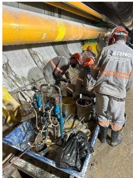
Figura 9 Checagem de todo sistema de injeção bi componentes
