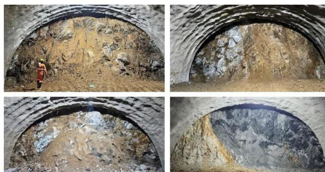
Figura 7 - Diferentes locais onde o suporte de face mista foi aplicado no mesmo túnel. Fonte: Autores.
