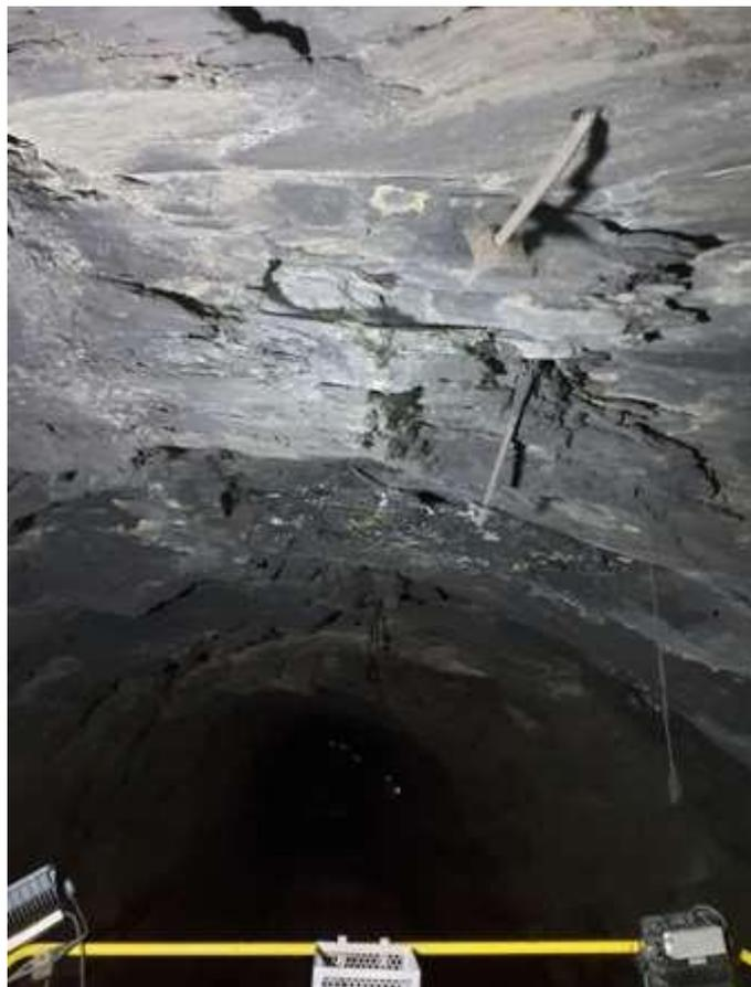
Figura 1: Abóboda do túnel com evidência de queda de blocos, barras de ferro de tirante/ chumbador expostas.
