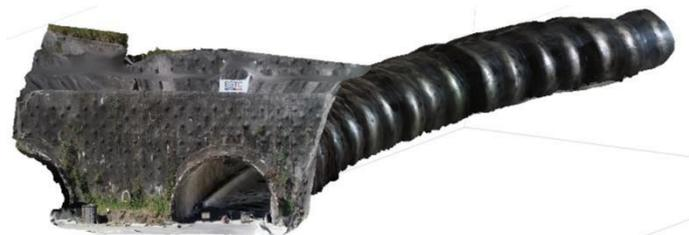
Figura 1 - Vista texturizada do modelo 3D do túnel reconstruído a partir de fotogrametria com drone.
