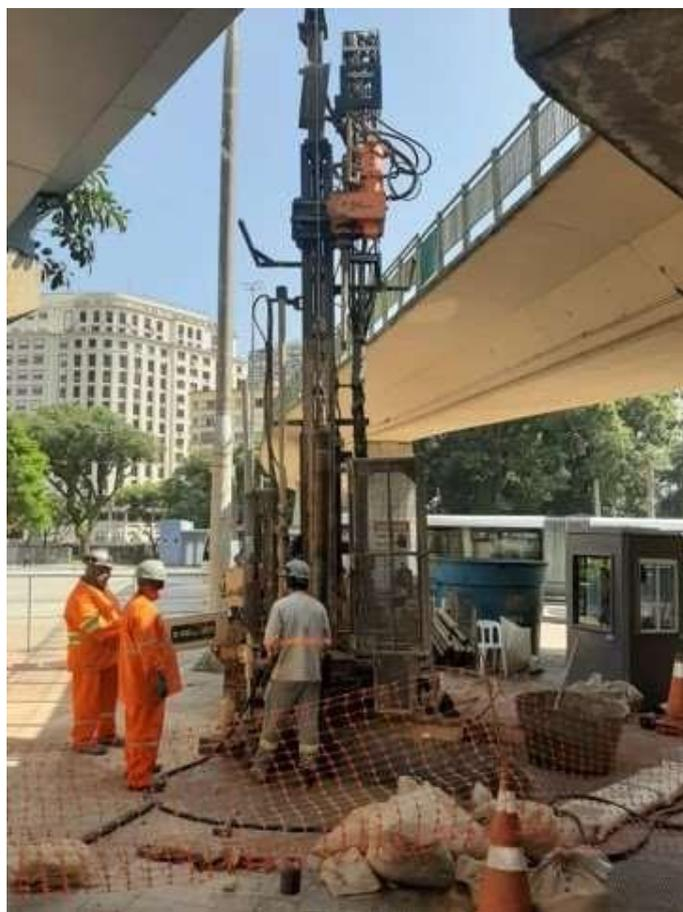
Figura 1. Sondagem em execução no Terminal Bandeira.
