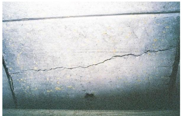
Foto 12. Embora os segmentos eram dotados de indutores de tensões, como se vê acima da fissura desta foto, nem sempre ocorriam neles. Fonte: Relatório Técnico elaborado pelo engenheiro Arsênio Negro Junior
