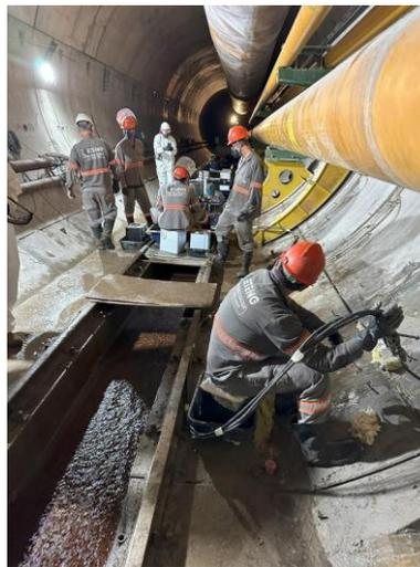
Figura 15 Tratamento de injeção com os bicos de injeção instalados
