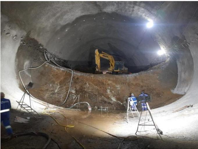
Figura 13. Execução do arco invertido definitivo, em dez/2024.
