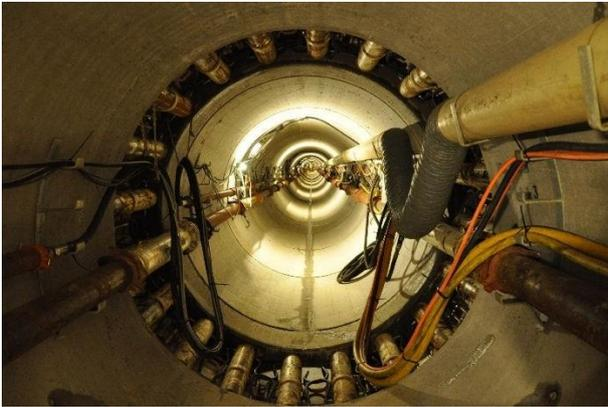
Foto 16. Estação intermediária em tubulação de 2,00 m de diâmetro. O conjunto de pequenos cilindros hidráulicos são acionados simultaneamente e não sobressaem ao diâmetro interno do tubo. Fonte: Group *Cogeis Ingegneria* (Itália).
