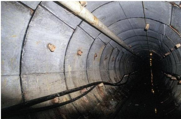
Foto 11. Mini túnel com anéis expansivos, diâmetro 1,50 m. Obra coletor-tronco do Carandirú. Fonte: acervo do autor.
