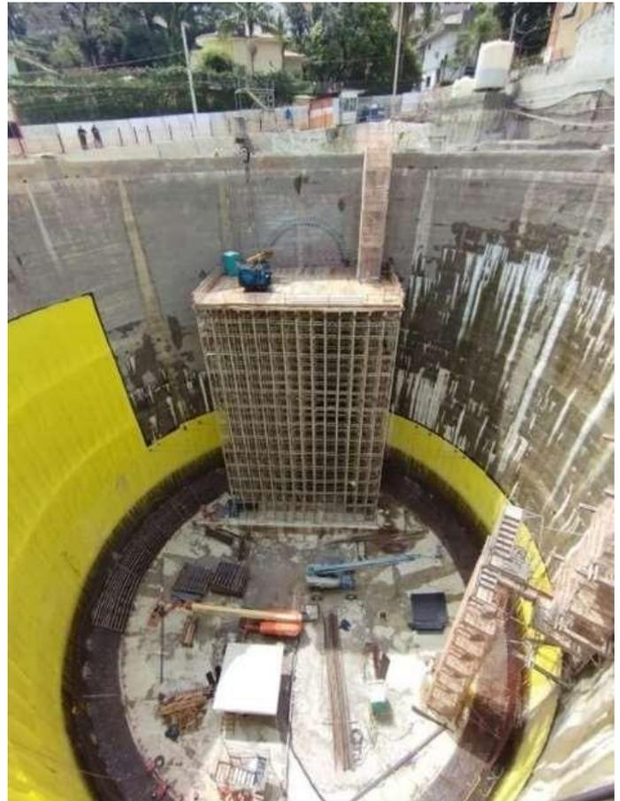
Figura 25. Túnel piloto - Posicionador "Kamasutra" na execução de camada dupla de CCPH na calota e septo frontal em CCPH.
