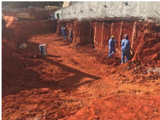
Figura 2. Frente de escavação do parâmetro com pré-contenção em estacas-raiz.
