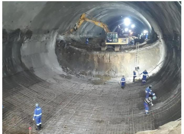
Figura 11. Execução do arco invertido definitivo, em dez/2024. Fonte: Autor.
