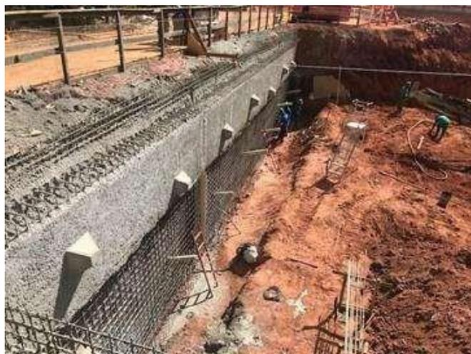
Figura 3. Cortina em execução após armação e tubos guias para tirantes.
