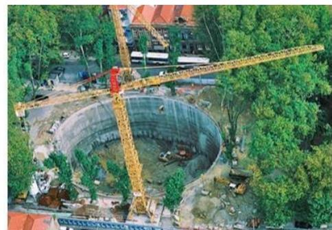
Figura 1. Poço elíptico - Estação Marquês. Fonte: CJC, 2005.
