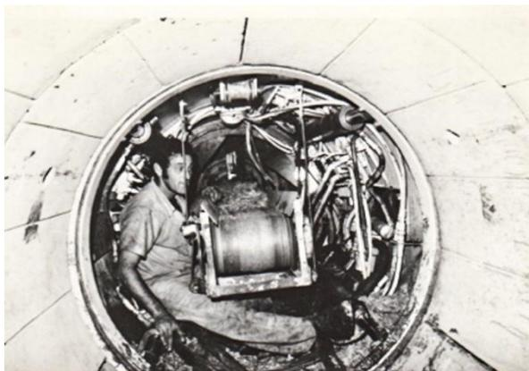
Foto 08. *Shield* “Lomec” diâmetro 1,20 utilizado na execução do coletor-tronco secundário da bacia do Tamandateí em 1983.
