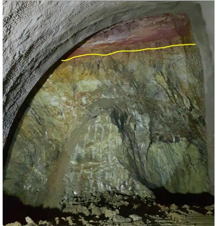
Figura 6 – Contato observado entre a Formação São Paulo (superior), com o Complexo Embu (inferior). Foto tirada no side drift direito do túnel de plataforma norte.
