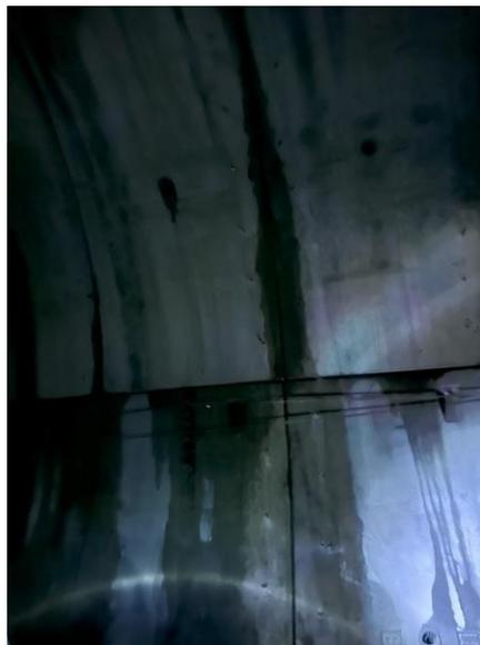
Figura 4 região com vazamento entre juntas
