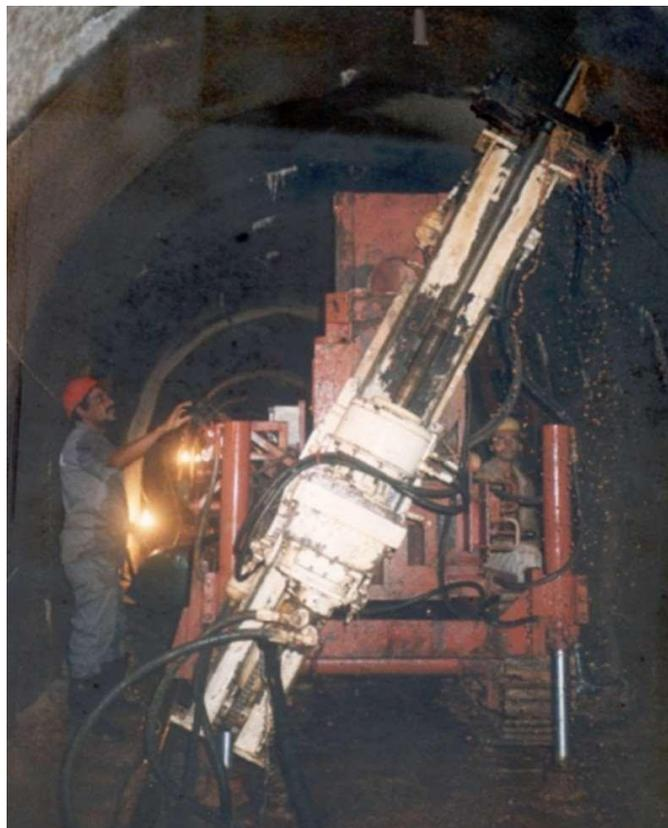
Figura 3. Perfuratriz para drenos subverticais pela galeria de drenagem.
